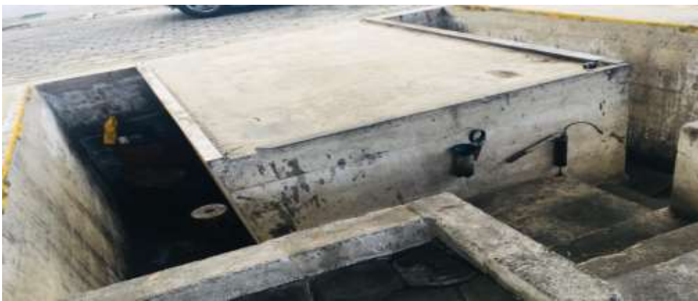
Gráfico 38 Fosa para lavado y cambio de aceite
