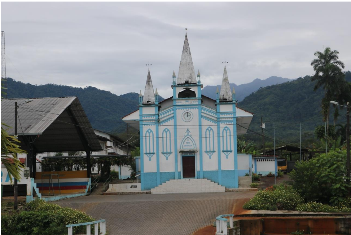
Iglesia Central Cotundo Fotografía: Davia Mancheno
