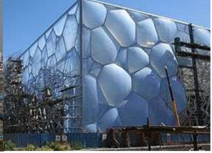
El Cubo de agua en construcción. Observe la estructura de Weaire-Phelan
